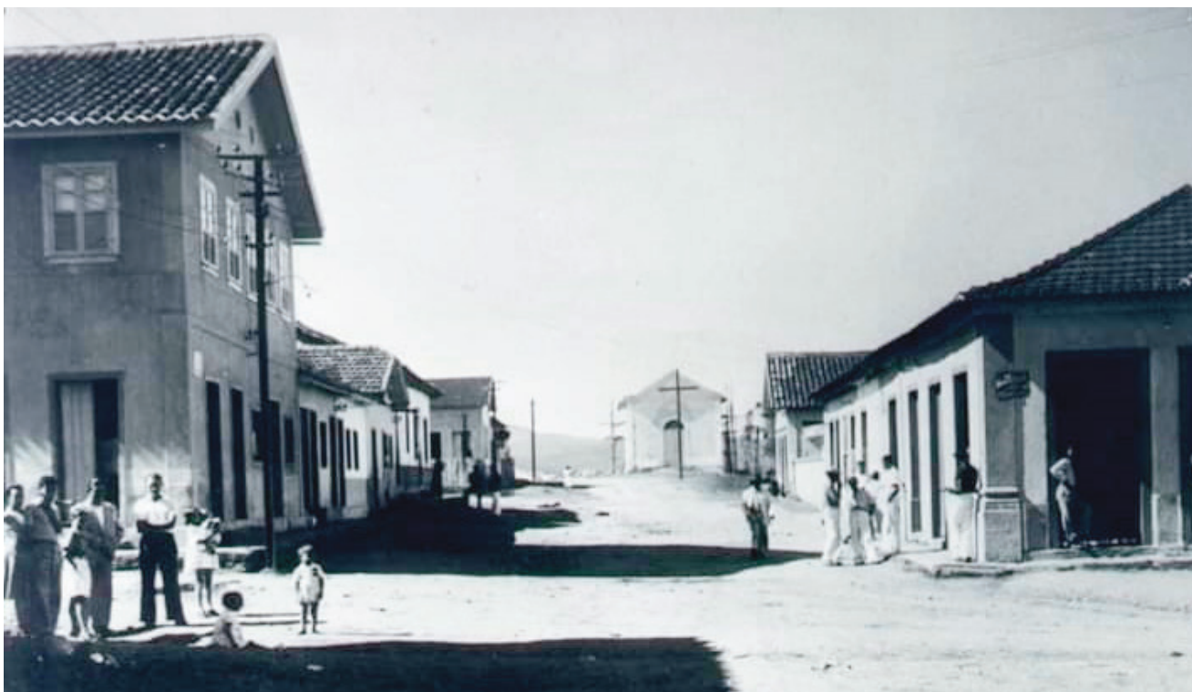
Ao lado, fotografia da rua principal, com paróquia ao fundo, do Arraial de Santo Antônio da Volta Redonda, atual bairro de Niterói, na cidade de Volta Redonda - RJ. Na próxima página operários montam armadura de sapata e articulação das colunas da Oficina Mecânica e de Caldeiras.
